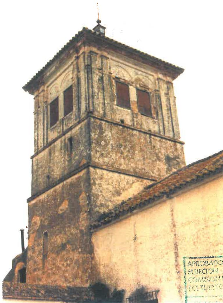
9. Desde un patio interior, torre mirador. Es cuadrada con huecos adintelados y enmarcados por pilastras gigantes y cubiertas de tejas.
