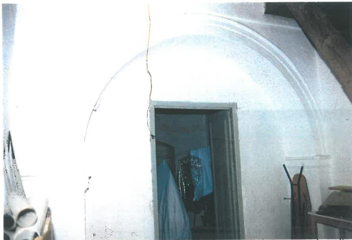
8. El muro central del cuerpo de fachada en el soberao se convierte en arcos de medio punto para obtener un espacio diáfano. En este caso se ha dividido con tabique. En la esquina superior derecha se observa la escalera de madera de acceso a la azotea.
