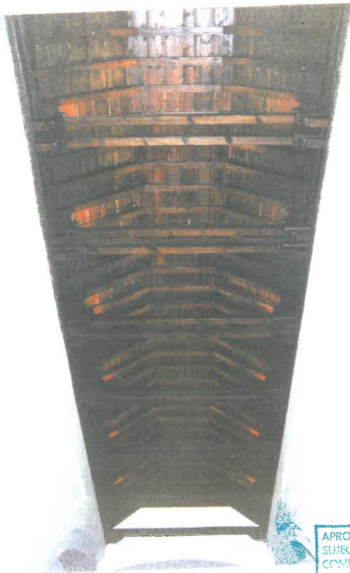
6. Detalle del alfarje que sostiene la cubierta de la nave central.
