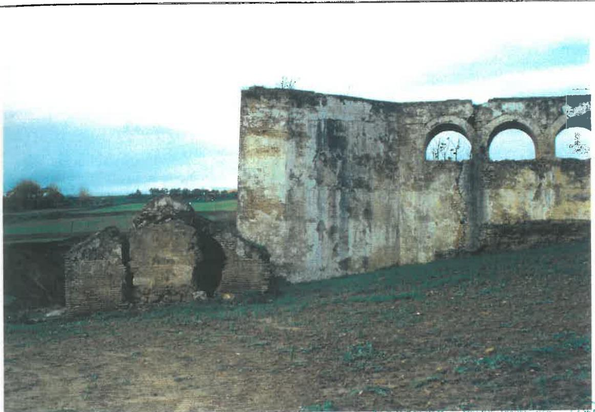
25. Alzado Sur. Sala del molino, muy deteriorada. Cubo y arcada del cao.
