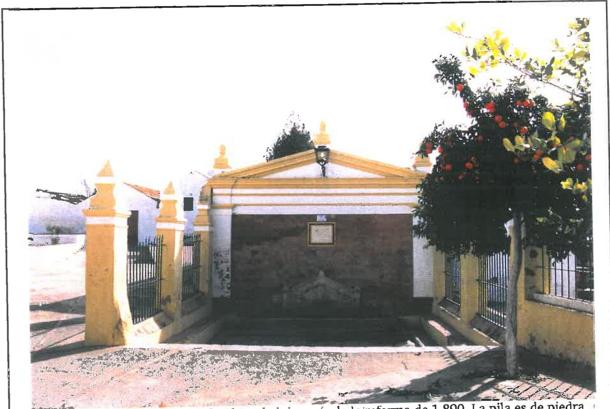
3. Frontal de la Fuente de Alconchel después de la reforma de 1.890. La pila es de piedra sobre un lienzo de ladrillo rematado por un frontón mixtilíneo; está cerrada por los laterales por pilares y rejas de hierro.
