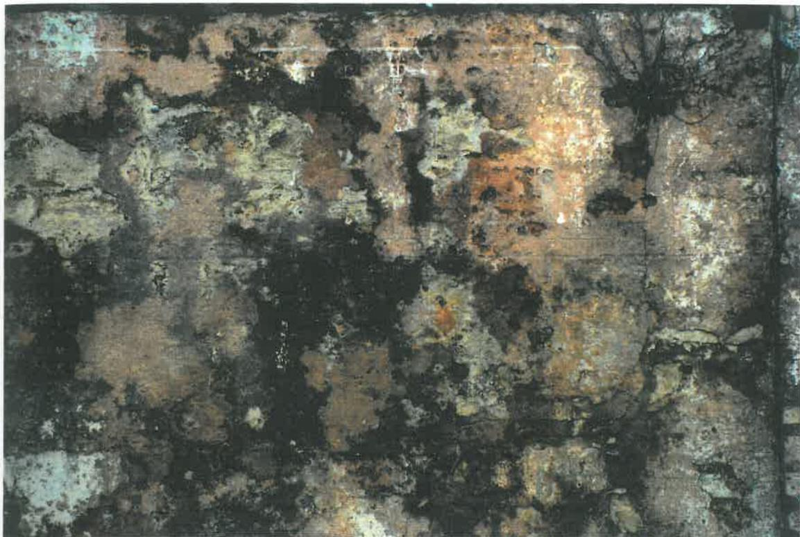
29. Detalle del esgrafiado de fachada muy deteriorado.
